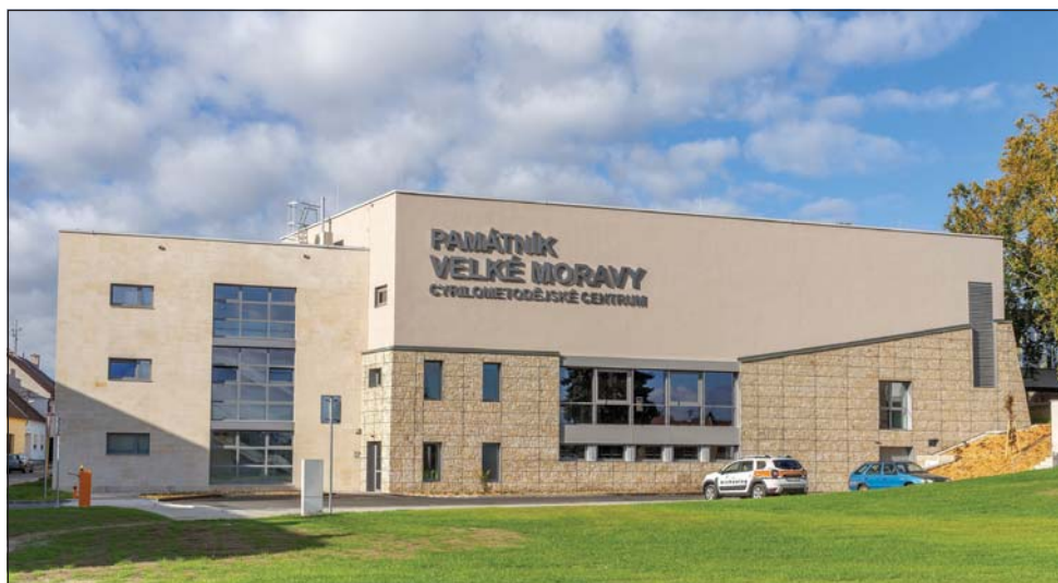
Objekt Cyrilometodějského centra po dokončení terénních úprav. Fotoarchiv Slováckého muzea v Uherském Hradišti (dále Fotoarchiv SM UH).
