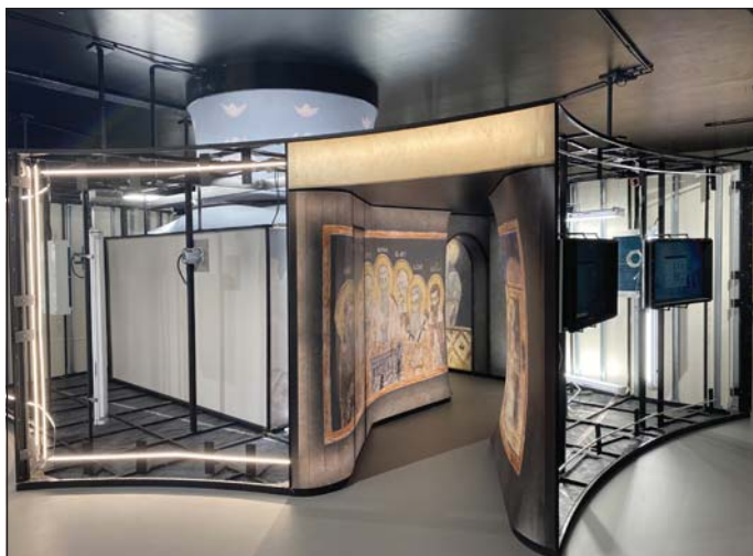
Expozice Příběh Konstantina a Metoděje – ocelová konstrukce s částečně napnutými foliemi.
