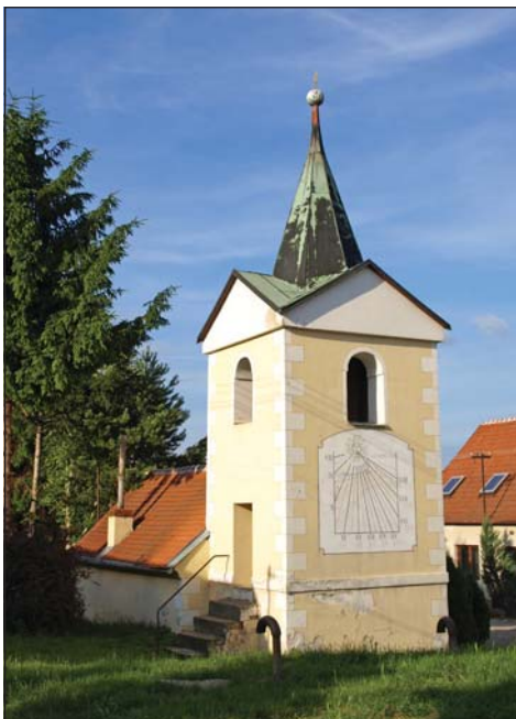
Zděná patrová zvonice ve Svatobořicích se slunečními hodinami, 2009. Foto J. Káčer. Fotoarchiv SM UH.
