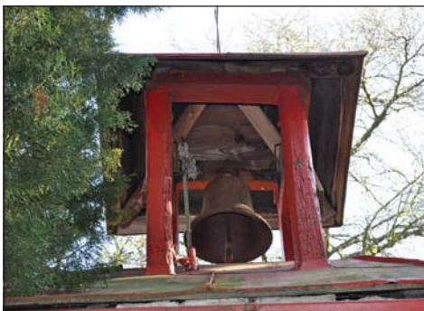
Kaple sv. Floriána se zvoncovým nástavcem v Silničné, 2022. Foto J. Káčer. Fotoarchiv SM UH.
