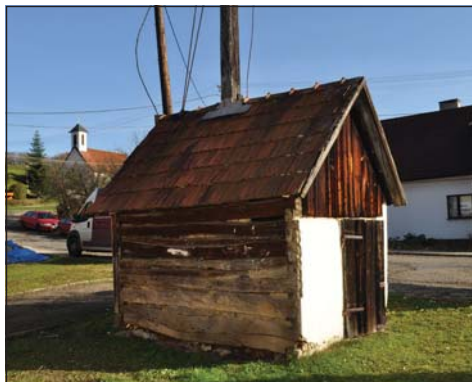
Roubená konstrukce zvonice na návsi v Kladné, 2019. Foto J. Káčer. Fotoarchiv SM UH.
