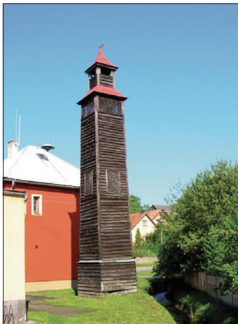
Dřevěná sušárna hadic se zvonice v Loučce za hasičskou zbrojnicí, 2012. Fotoarchiv OÚ Loučka.
