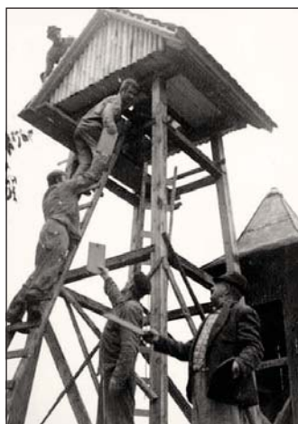
Stavba poslední dřevěné zvonice v těsném sousedství hasičské zbrojnice, okolo roku 1980. Zdroj: Kronika obce Dolní Lhota.
