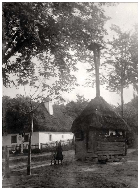
Roubená zvonice v Dobrkovicích, 1917–1929. Foto A. Václavík. Fotoarchiv Muzea jihovýchodní Moravy ve Zlíně (dále MJVM Zlín).
