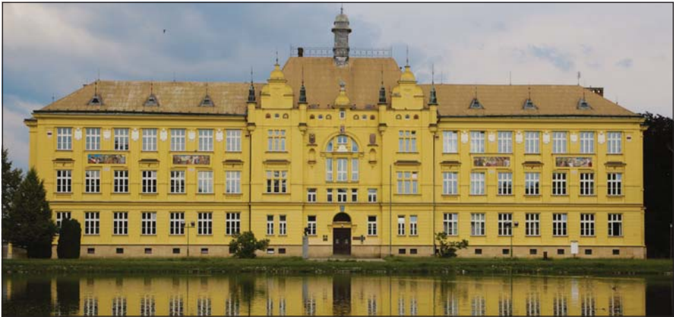
Obr. 4. Průčelí budovy reálky v Litovli, 1904. Foto V. Říhová.
