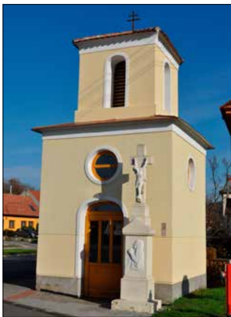
Zděná zvonice na návsi v Záhorovicích, 2019. Foto J. Káčer. Fotoarchiv SM UH.
