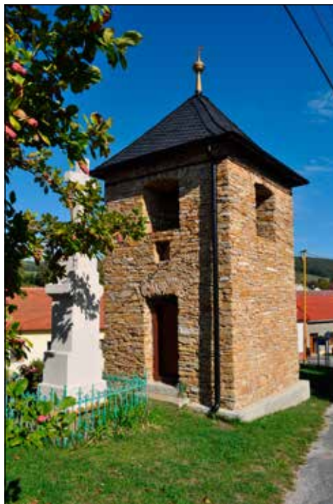
Zvonic zděná z lomového kamene v horní části návsi v Bystřici pod Lopeníkem, 2019. Foto J. Káčer. Fotoarchiv SM UH.
