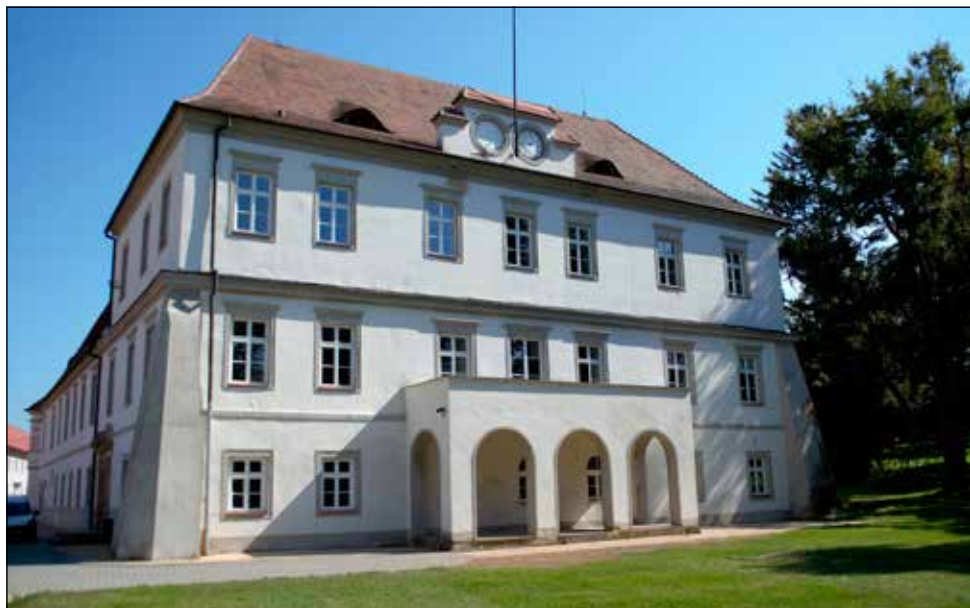
Obr. 2. Pohled na budovu zámku od JZ. Foto J. Bartík.
