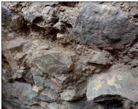
Obr. 11. Detailní pohled na odskočení dvou fází zdiva v sondě 1. Foto J. Bartík.
