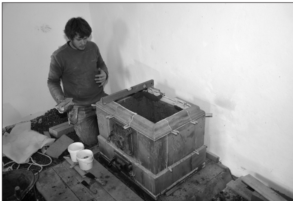
Stavba kachlových kamen kamnářem Vojtěchem Janečkem z Uherského Hradiště-Mařatic v expozičním objektu z Boršic čp. 288, 2015. Foto J. Blahůšek.
