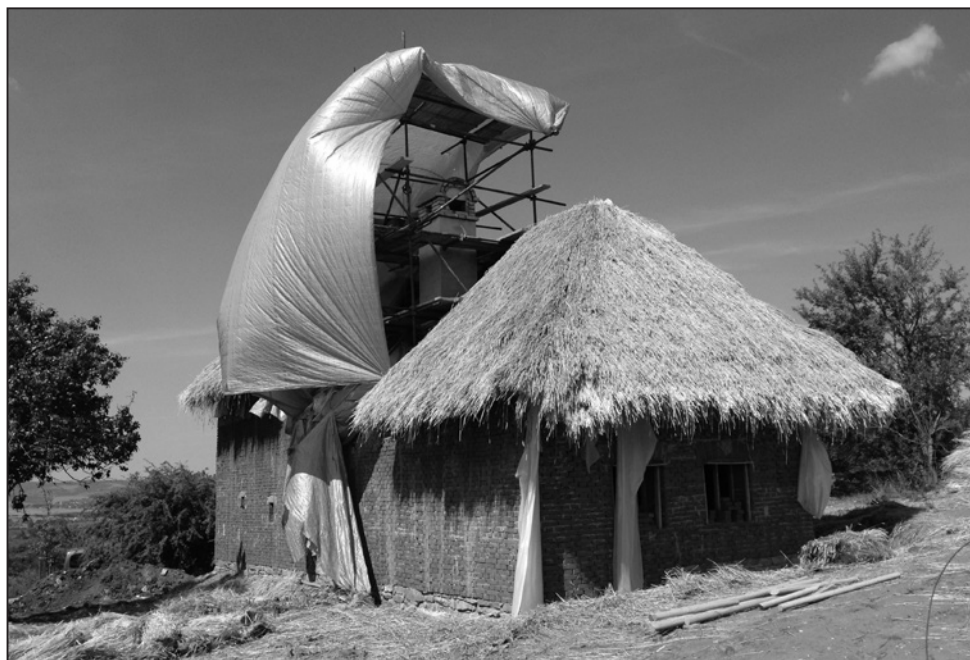
Kopie objektu z Veletin čp. 25 – objekt ve fázi realizace doškové střechy a dokončování výstavby komínové hlavy v srpnu 2015. Foto J. Blahůšek.
