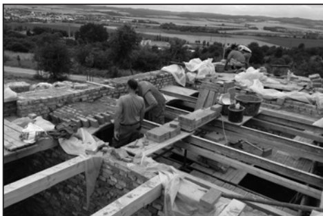
Výstavba kopie objektu z Boršic čp. 288 – stropní klenby nad chlévem, 2015. Foto J. Blahůšek.
