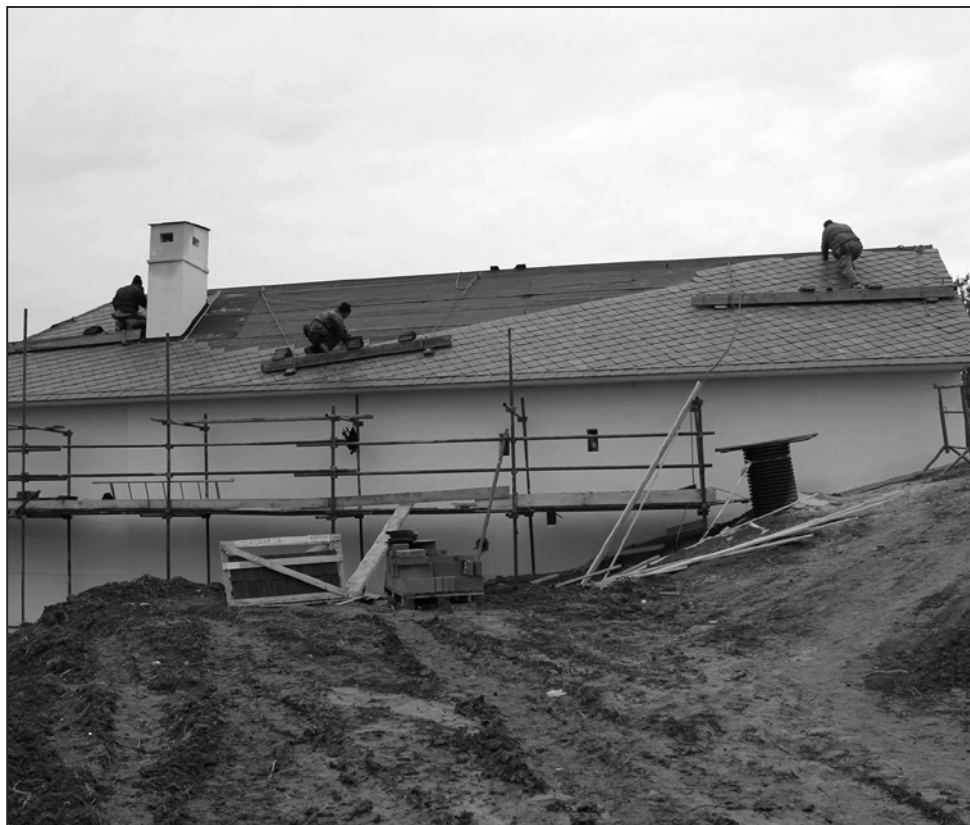
Pokrývání střechy břidlicí na nadsklepním domem z Tučap. Foto J. Káčer, fotoarchiv Parku Rochus, o.p.s., 2015.
