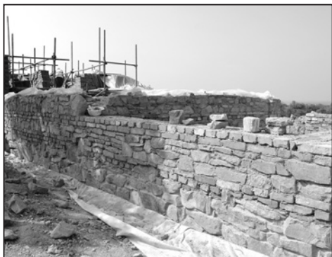
Kombinované zdivo na hliněnou maltu hospodářského křídla usedlosti z Boršic. Foto J. Káčer, fotoarchiv Parku Rochus, o.p.s., 2015.
