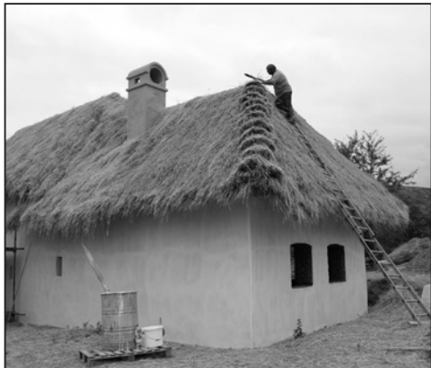
Pokryvání střechy doškem Františkem Pavlicou. Foto J. Káčer, fotoarchiv Parku Rochus, o.p.s., 2015.
