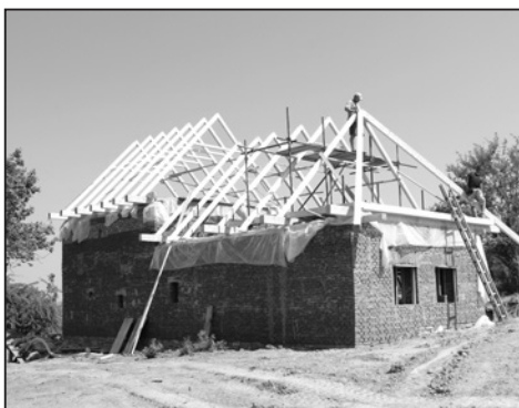
Stavba krovu nad objektem z Veletin. Foto J. Káčer, fotoarchiv Parku Rochus, o.p.s., 2015.
