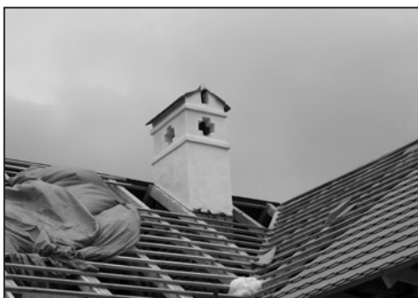
Dokončená komínová hlava nad zemědělskou usedlostí z Boršic. Foto J. Káčer, fotoarchiv Parku Rochus, o.p.s., 2015.
