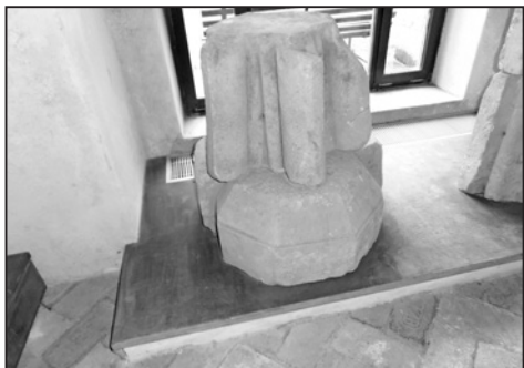
Současná expozice, na obrácené konzole je postaven opět obrácený náběh klenebních žeber. Foto M. Pojsl.
