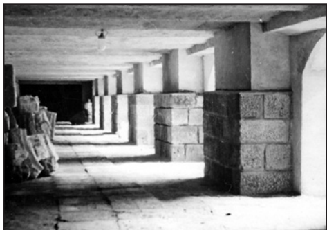
Křížové chodby na počátku čtyřicátých let 20. století po rozebrání barokních základů a vybudování nových základových pilířů. Foto J. Pojzl, fotoarchiv Slovákého muzea v Uherském Hradišti.
