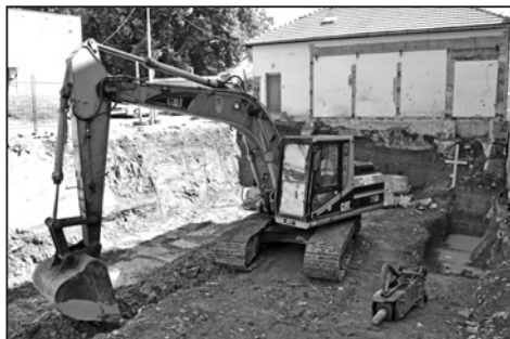
Obr. 3. Pohled na stavební jámu od jihozápadu ve fázi bagrování. Foto J. Bartík.
