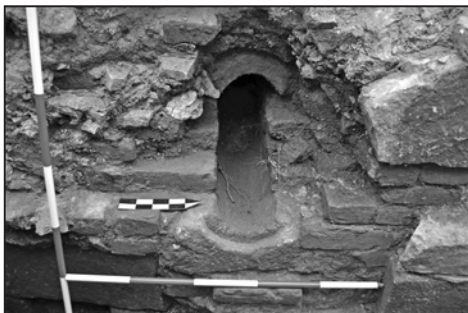
Obr. 4. Detail raně novověké odpadní výpustě vezděné do tělesa původní vrcholně středověké hradby. Foto J. Bartík.
