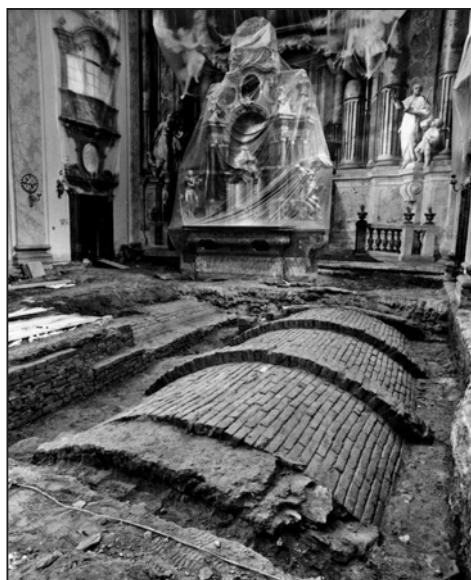
Obr. 5. Klenba západní krypty – A v hlavní lodi kostela sv. Františka Xaverského po povodni v roce 1997, stav při rekonstrukci 1998. Foto-archiv Slováckého muzea v Uherském Hradišti. Foto L. Chvalkovský.
