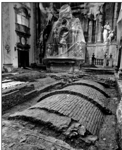
Obr. 5. Klenba západní krypty – A v hlavní lodi kostela sv. Františka Xaverského po povodni v roce 1997, stav při rekonstrukci 1998. Foto-archiv Slováckého muzea v Uherském Hradišti. Foto L. Chvalkovský.
