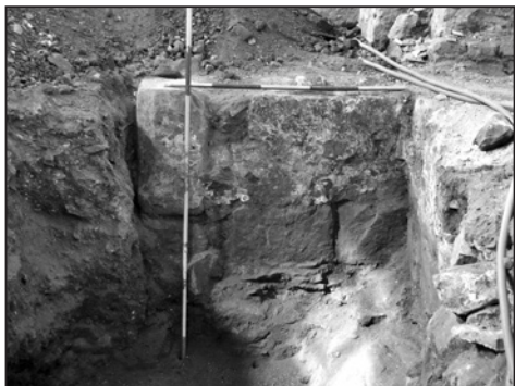
Obr. 1. Pohled na odkryté základy a část opěrného pilíře v jihozápadní části lodi kostela, 13. století. Foto M. Vaškových.
