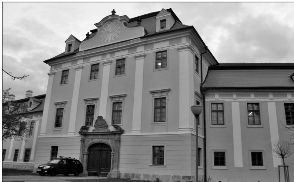
Obr. 1. Celkový pohled na vstupní objekt do internátu Stojanova gymnázia Velehrad s portálem z roku 1769, Velehrad 2011. Foto Z. Schenk.
