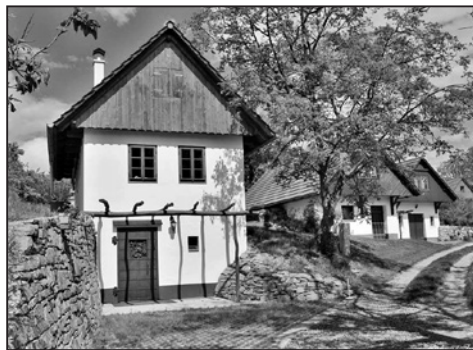
Podsklepená novostavba na parc. č. 269, Mařatice 2013. Foto R. Janda.
