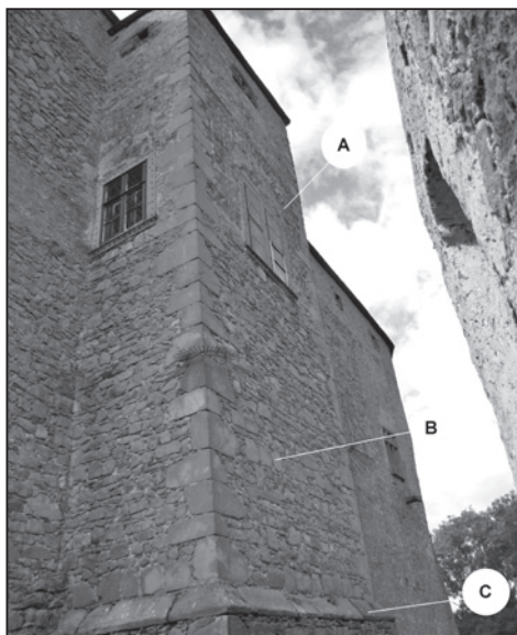
Obr. 6. Hrad Buchlov, pohled na hranolový rizalit s vyznačením detailů uvedených v textu; pohled od severovýchodu, Buchlov 2012. Foto R. Vrla.
