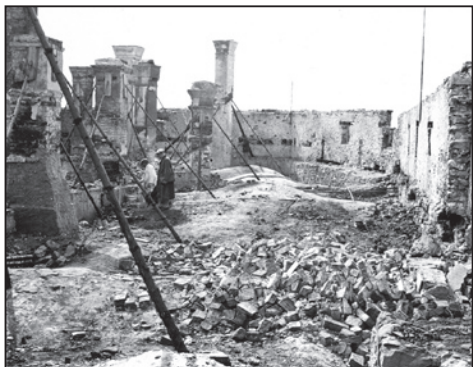
Obr. 12. Hrad Buchlov, historická fotografie půdy severního traktu po požáru v roce 1931, pohled od jihu; napravo je destruovaná partie při západní zdi hranolového rizalitu (je zde patrná sendvičová konstrukce zdiva, líc pravé části zdi je zřejmě opatřen omítkou). U paty levé části se rýsuje otisk po horizontálním trámu – průběh dřevěné konstrukce je dále vidět až téměř k severozápadnímu nároží v pozadí. Kolem okénka v průhledu (napravo od nároží) jsou patrné dva symetricky situované svislé tmavší pásy (pravděpodobně opět jizvy po dřevěných konstrukcích). Dále vlevo je na vnější stěně patrná vodorovná tmavá linie (zdivo bez omítek). V popředí před vstupem do rizalitu je zachycena hromada suti ze zříceného zdiva, obsahujícího převážně vysoké cihly („prstovky“). Snímek z roku 1931. Fotoarchiv Národního památkového ústavu, územního odborného pracoviště v Brně.
