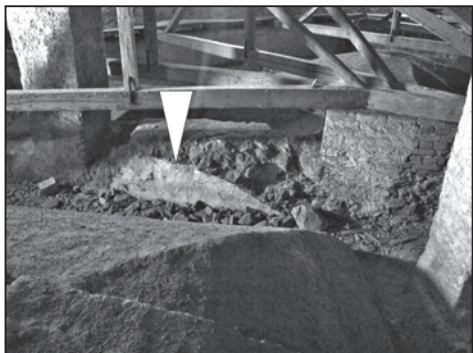
Obr. 11. Hrad Buchlov, půda, detail severozápadního lince zdi, dělící v patře místnosti č. 26 a 27; bílá šipka ukazuje na fragment omítky klenebního čela s pozůstatky zdiva klenby, pohled od jihu, Buchlov 2012. Foto R. Vrla.
