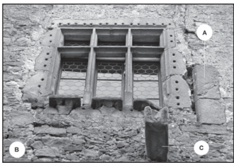
Obr. 7. Hrad Buchlov, detail západního okna rytířského sálu (místnost č. 24, srovnej obr. 4B); A – fragment ostění staršího okna (v původní poloze), B – druhotně přemístěný fragment ostění staršího okna, C – barokní výlevka; pohled od severu, Buchlov 2012. Foto R. Vrla.
