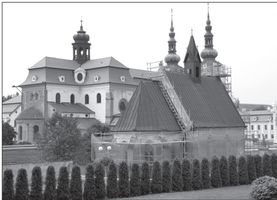
Obr. 1. Kaple Cyrilka, celkový pohled od severovýchodu v průběhu stavebních prací, Velehrad 2012. Foto R. Vrla.
