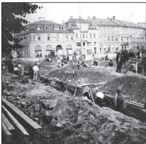
Obr. 13. Kopání protiletického krytu v Uherském Hradišti na dnešním Masarykově náměstí na přelomu let 1943 a 1944. Neznámý autor, fotoarchiv SM UH.
