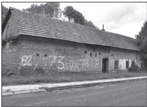
Jankovice – zemědělská usedlost čp. 116 Metoděje Hrbáčka postavená v roce 1820. Foto J. Káčer.
