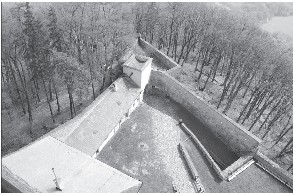
3. Hrad Buchlov; pohled z hradního jádra na část jihovýchodního opevnění hradu; uprostřed věž s průjezdem 1. brány, nad ní bastion. Nalevo od věže severní část opevnění s objektem, obsahujícím vřátnici, napravo část jižního úseku opevnění.
