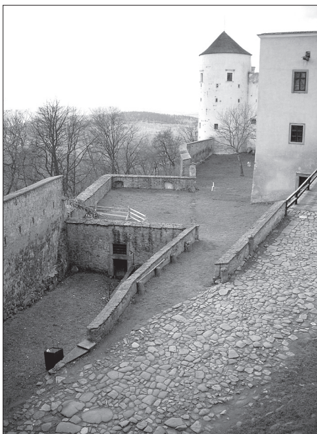
15. Hrad Buchlov; pohled na podsklepený objekt od severovýchodu; nalevo vnitřní líc jižního úseku hradby, napravo od něj vstup do sklepa, nad ním plocha bývalého objektu, ještě výš další průběh hradby s tupoúhlým nárožím. V pozadí věž Andělka, napravo východní nároží objektu druhé brány.
