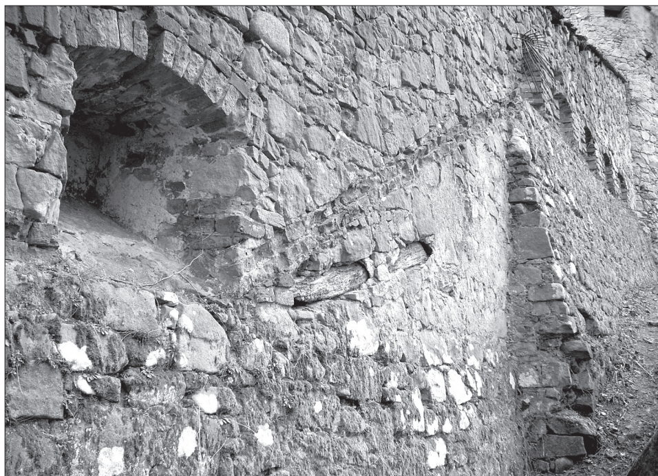
12. Hrad Buchlov; detail vnější fasády jižní hradby; vlevo zazděná střilna, napravo od ní stoupající úsek odsekané, cihlové římsy, pod ní zazděný trám, nacházející se zřejmě nad zrušenou vstupní šíjí sklípku.
