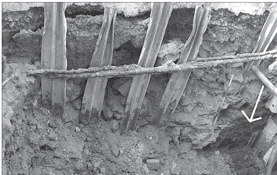
12. Ulice U Reduty 2007. Situace vnitřní hradební zdi s jílovým základovým zářezem do tmavé, humózní středohradištní vrstvy (označeno šipkou). Foto D. Menoušková.
