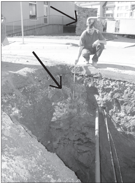
6. Zachované zdivo hradby v křižovatce ulic Dlouhá a Sojákovy, pohled na jihozápadní profil. V pozadí patrné dochované nadzemní torzo. Hradba ve výkopu i stojící hradba označeny šipkami. Foto D. Menoušková.
