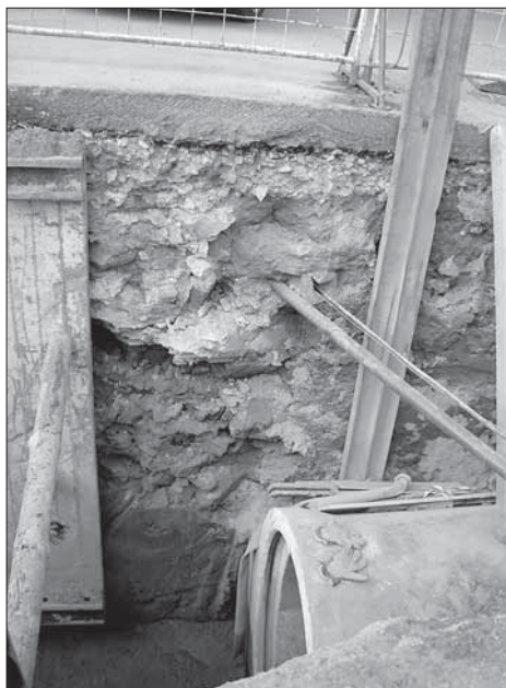
13. Uherské Hradiště, oprava kanalizační stoky „V“, třetí etapa 2008, křížení ul. Dlouhé a Sojákovy. Situace středověké kamenné hrady, jihozápadní profil. Foto D. Menoušková.
