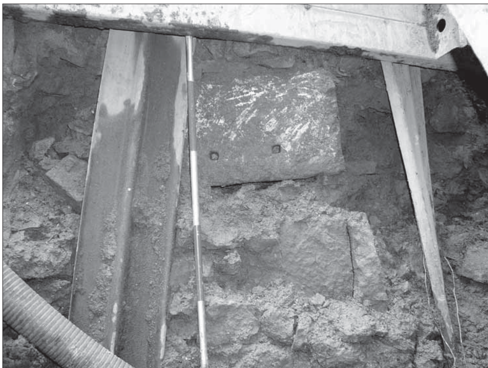
9. Uherské Hradiště, oprava kanalizační stoky „V“, druhá etapa 2007, ul. U Reduty, druhotně užitě ostění renezančního okna s otvory pro mříže ve vnější hradební zdi, severovýchodní profil. Foto D. Menoušková.
