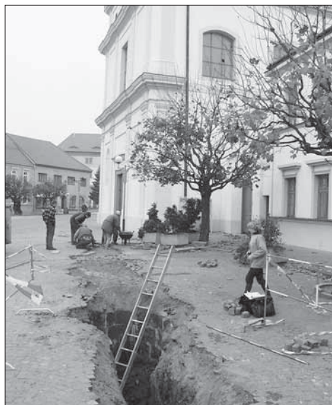
18. Uherský Ostroh, nám. sv. Ondřeje, před farou, 2005. Celkový pohled na lokalitu, uprostřed studna vydlážděná kamennými bloky protnutá výkopem kanalizace. Foto M. Jordán.
