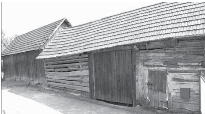
Popov, dřevěné samostatně stojící stodoly roubené a rámové konstrukce.
