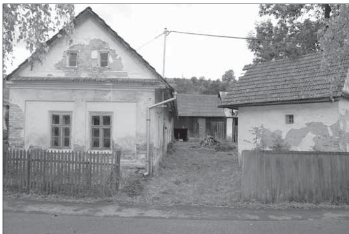
Nedašov, zděná štítová usedlost čp. 69 s patrovou komorou.
