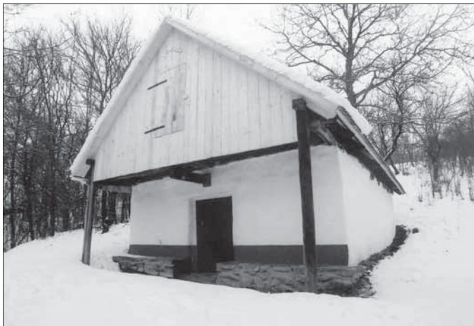
Vinohradnická stavba tzv. „búda.“
