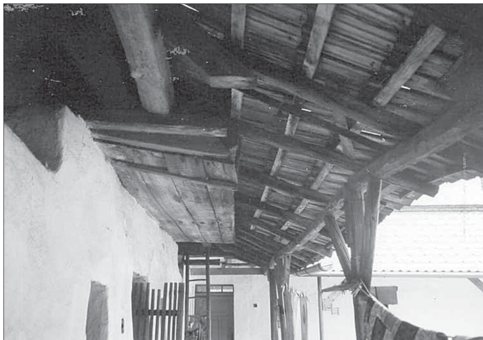
Dvorní hospodářské křídlo dokládající staré technologické postupy.
