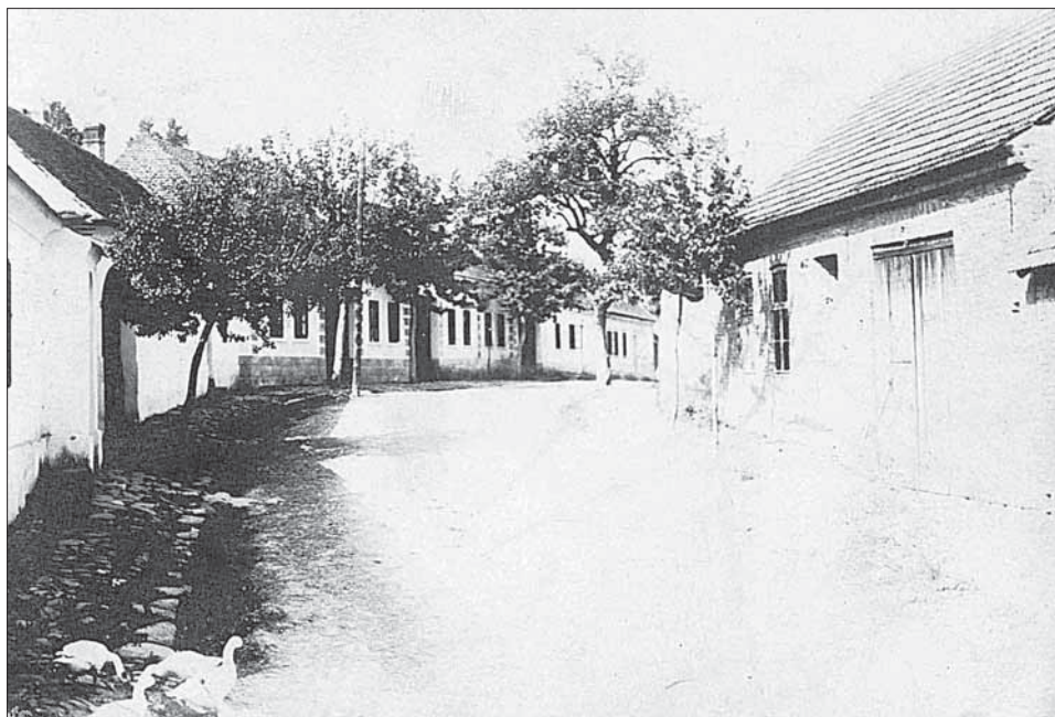
6. Zástavba podsednických usedlostí v ulici mezi Horním a Dolním rynkem. Foto archiv autora, okolo 1930.
