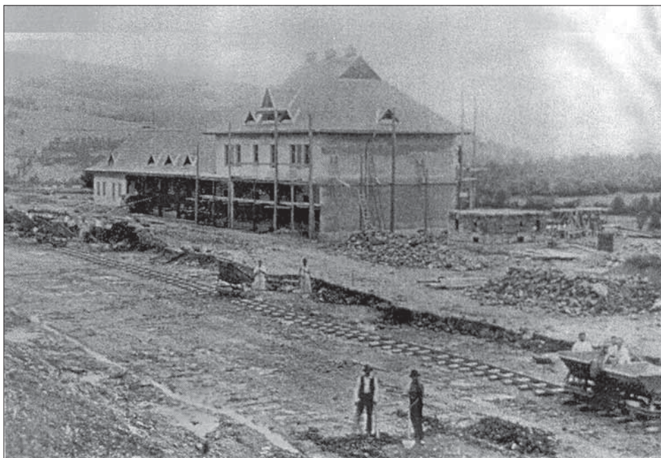
2. Počas stavby železnice sa vybuďovali mnohé nové staničné budovy.
