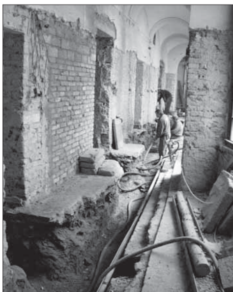
19. Pohled do arkádové chodby západního zámeckého křídla v průběhu výzkumu. Foto J. Kohoutek.
