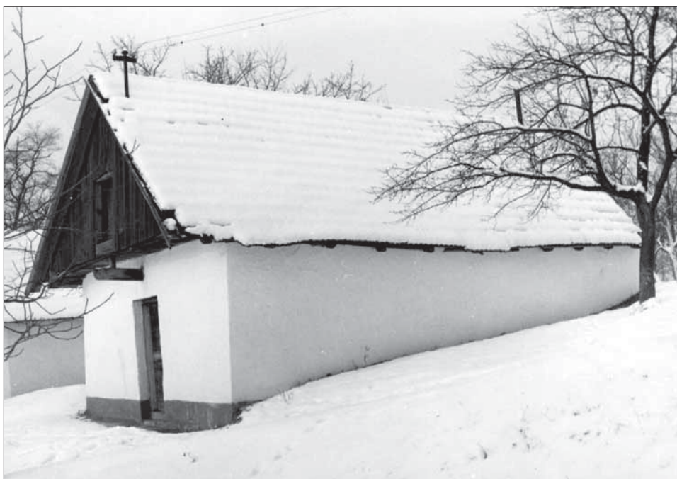
3. Vinná bída s předsazeným bedněným štítem před obnovou. Vlčnov.
